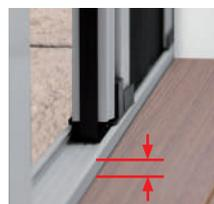
Spessore della guida a pavimento di soli 8 mm
